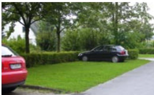
Czasowo wykorzystywany parking z nawierzchnią KRESCAT
